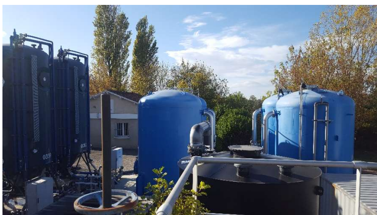
FONNEUVE : Filtres à démonter
